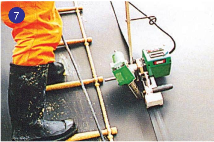
TWINNY “T” 熱風雙輪傳動式自動焊接機，無論是上坡、下坡或是倒立焊接，都能輕鬆自如。
