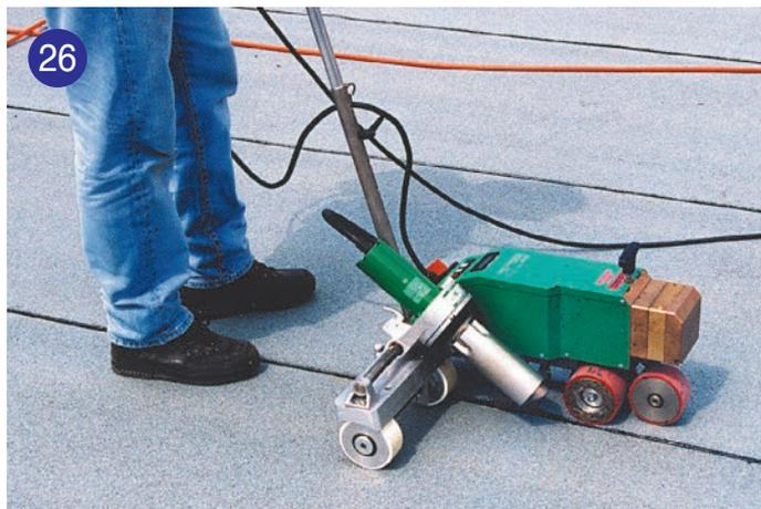
VARIMAT可適用在離牆邊只有100mm的距離做焊接工作。
