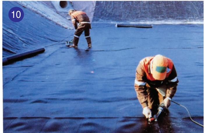
型號X84及TRIAC “S” 可用於垃圾場及水池隔水布材之焊接工程。
