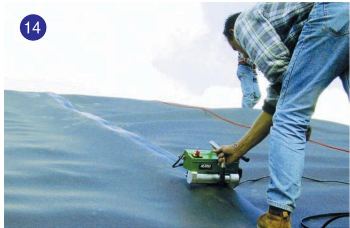
14 ASTRO用在PE防水膜上的斜坡焊接，速度最高5米每分鐘。
