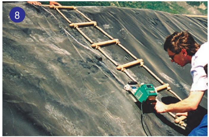
如果你的皮料在0.75mm以上，COMET電熱刀雙輪傳動式自動焊接機，將是您最好的戶外焊機。
