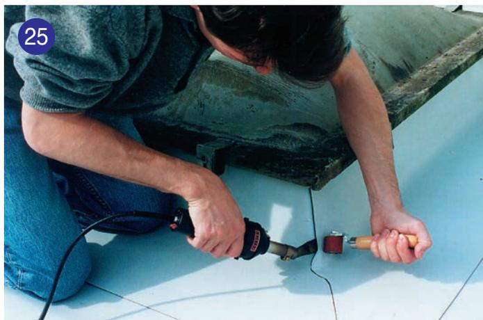
屋頂通風角落的手焊，LEISTER工具有多種機型提供您的適用。
