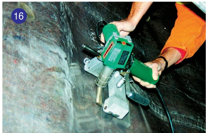
16 TWINNY S配上管式焊嘴解決礦場上0.3毫米的PE焊接問題。
