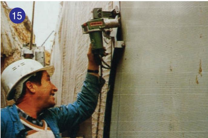
15 X84可使用在建築物內外牆90度垂直自動焊接，而且壓力不變，焊接及焊溫可調。
